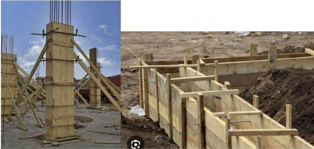
Se utilizarán tirantes y abrazaderas en los encofrados para mantener exactamente el espesor de pared especificado. Las tirantes abrazaderas serán de un tipo tal, que, después que se hayan quitado los encofrados, ninguna parte metálica quede a menos de 2.0 cm. de la superficie.
