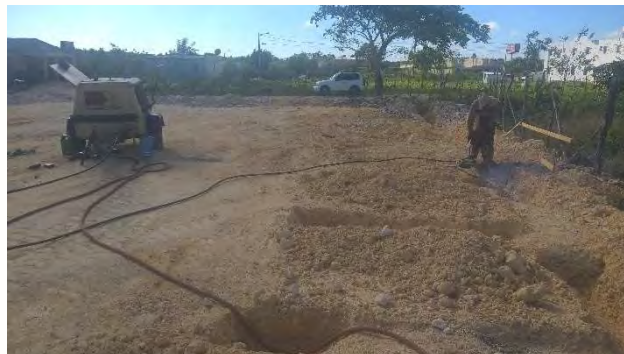
COMPRESOR HIDRAULICO DE 2 PISTOLAS INGERSOLLRAND
