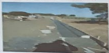
CONSTRUCCIÓN ACERAS Y CONTENES EN LA COMUNIDAD DE CELESTINA
